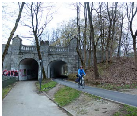
Viel besser: Der Tunnel unter der Max-Josef-Brücke
